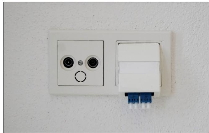
Die Anschlüsse enden an einem zentralen Punkt in der Wohnung, der für die Montage des Routers vorgesehen ist.
